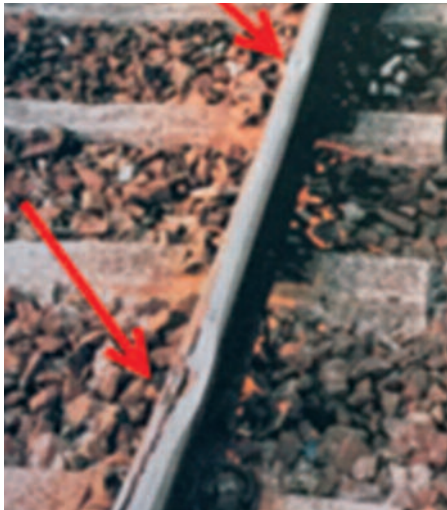
Gleich an zwei Stellen war 1999 das Güterbahngleis in Höhe der Berberitzenstraße geborsten und nur durch Zufall war dies bemerkt worden.
